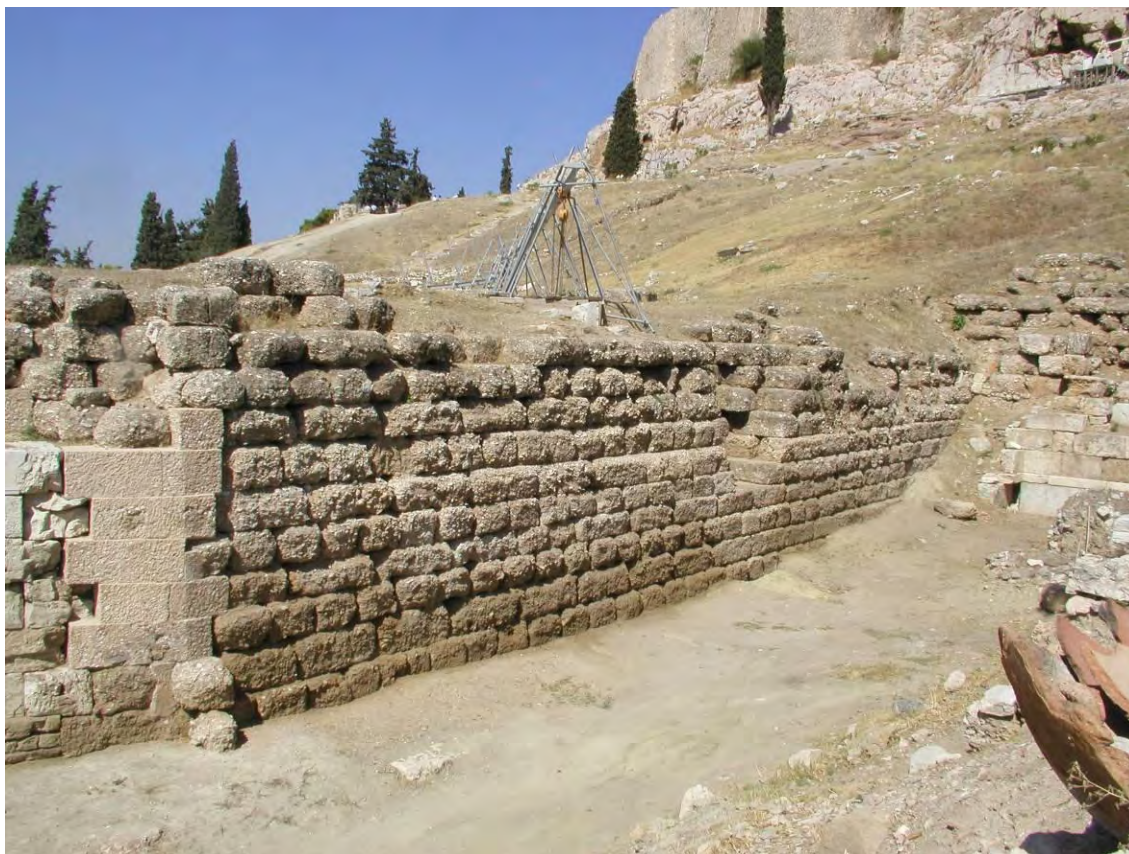
Το ανατολικό πλευρικό ανάλημμα πριν την έναρξη των εργασιών
