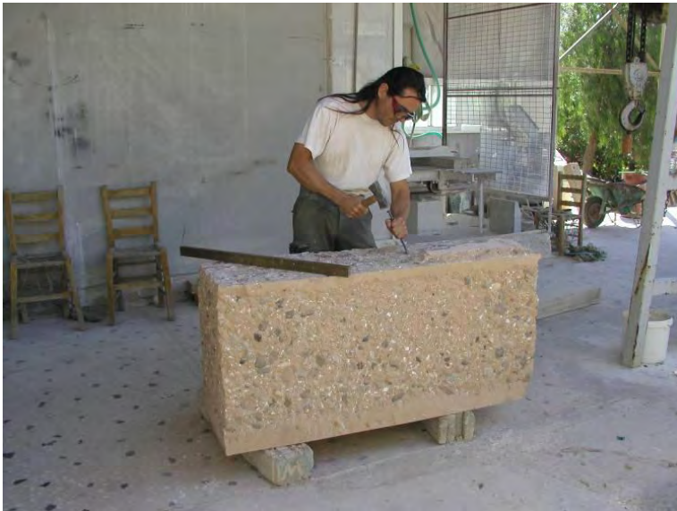
Στιγμιότυπο από τη λάξευση λιθοπλίνθου από τεχνητό κροκαλοπαγή λίθο
