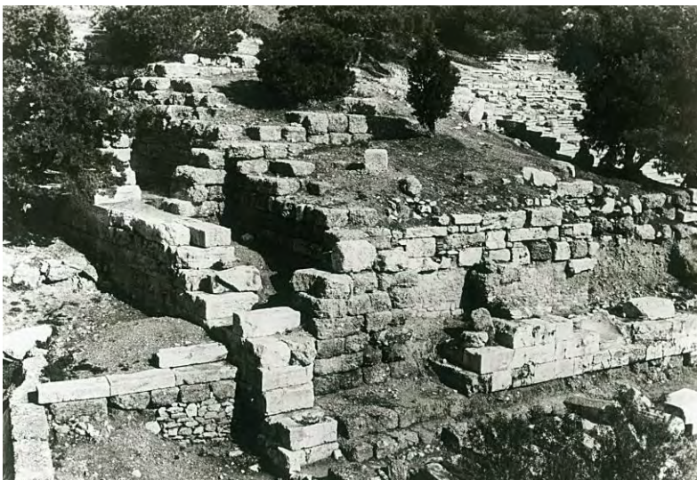
Το ανάλημμα της δυτικής παρόδου πριν την αποκατάσταση
