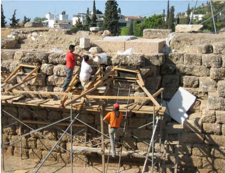
Στιγμιότυπο από τη χύτευση συμπληρωμάτων των κροκαλοπαγών λίθων του αναλήμματος
