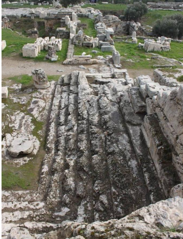
Εικ. 14. Εδώλια της νότιας πλευράς: Απώλεια υλικού και διάβρωση της βραχώμαζας.
