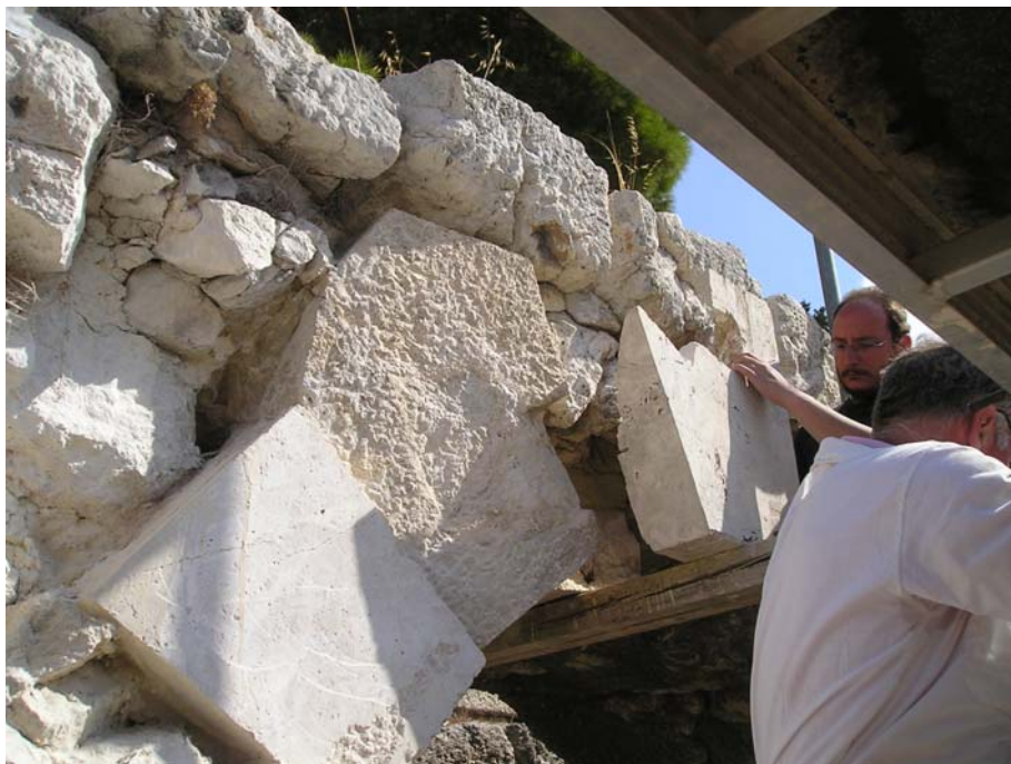
Εικόνα 23: Τοποθέτηση συμπληρωμάτων στους θολίτες του τόξου.
