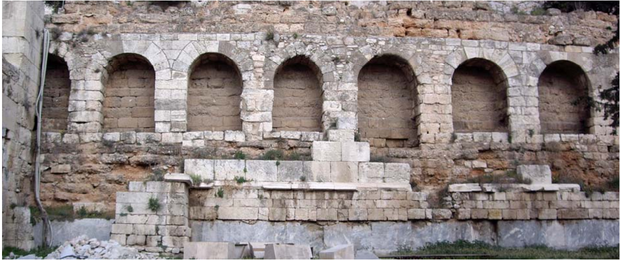
Εικόνα 11: Το αναστηλωμένο από τη δεκαετία του '60, Δυτικό τμήμα του Βόρειου τοίχου.
