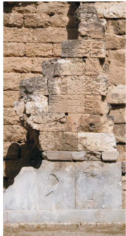
Εικόνα 15: Το καλύτερα σωζόμενο τμήμα της τοιχοποιίας από αιγινήτη λίθο περίπου στο μέσο του βόρειου τοίχου.
