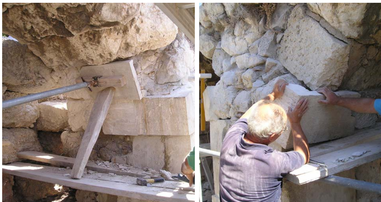
Εικόνες 21-22: Κατασκευή συμπληρωμάτων στους θολίτες των ακραίων ανατολικών τόξων του βόρειου τοίχου.
