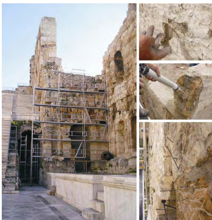
Εργασίες στερέωσης του Νότιου και των μετωπικών Τοίχων της Σκηνής του Ωδείου.
