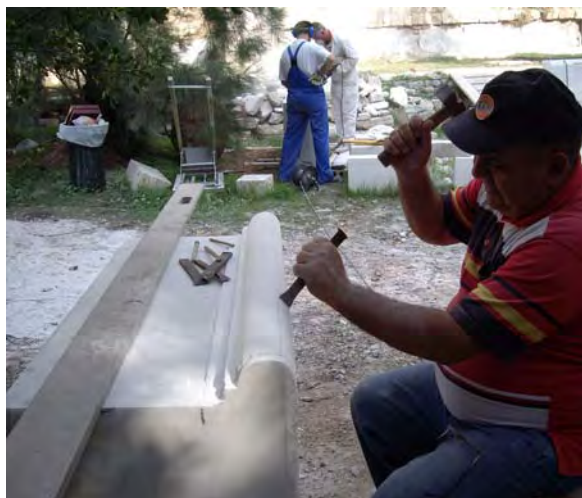
Εργασίες κατασκευής και τοποθέτησης 6 νέων σειρών εδωλίων στη Δυτική πάροδο.
