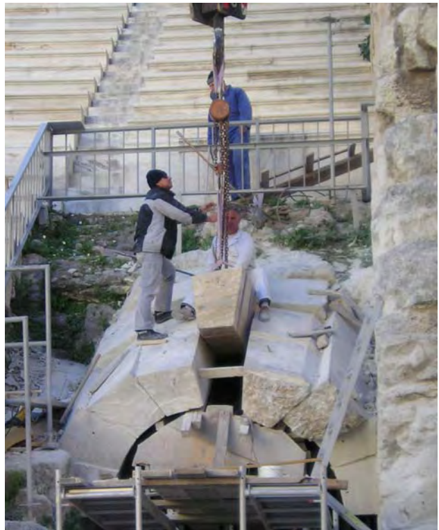
Τοποθέτηση των θολιτών και προσαρμογή του κλειδιού στην τελική τους θέση.
