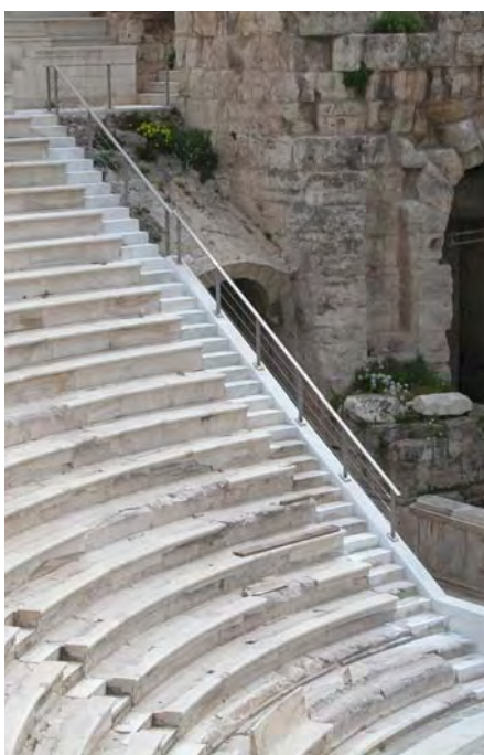
Το νέο από ανοξείδωτο χάλυβα κιγκλίδωμα στις ακραίες κλίμακες του κοίλου.
