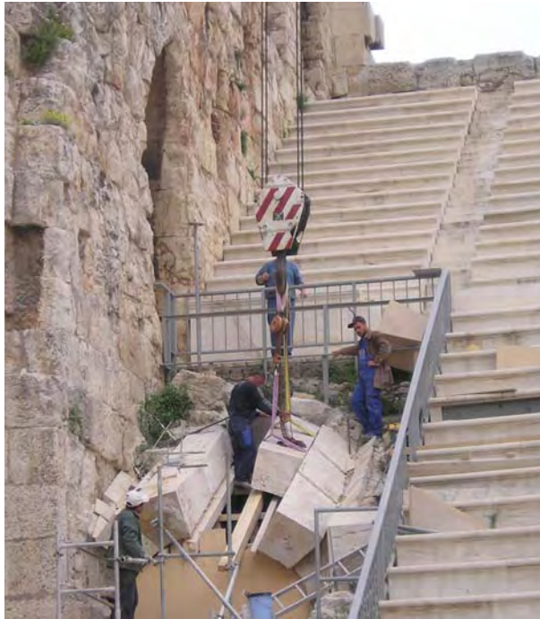
Τοποθέτηση των θολιτών του κλειδιού και προσαρμογή στην τελική τους θέση.
