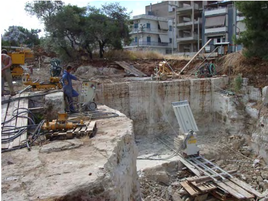
Εργασίες λατόμευσης πειραιϊκού ακτίτη στο Χατζηκυριάκειο Ίδρυμα.
