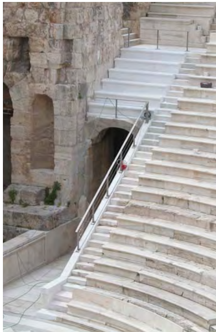
Το νέο από ανοξείδωτο χάλυβα κιγκλίδωμα στις ακραίες κλίμακες του κοίλου.
