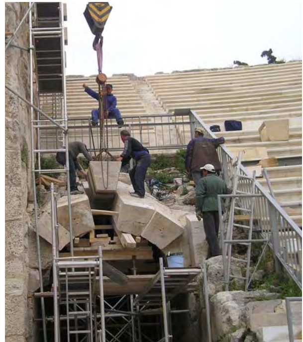
Τοποθέτηση των θολιτών του κλειδιού και προσαρμογή στην τελική τους θέση.
