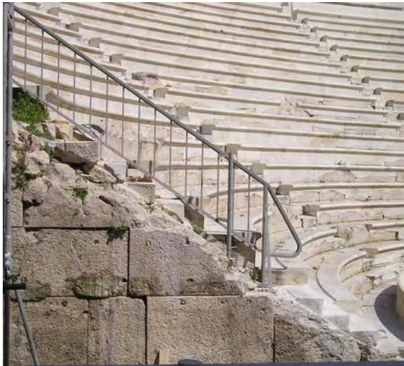
Το πώρινο στηθαίο της ακραίας δυτικής κλίμακας πριν και μετά την αναστήλωση.
