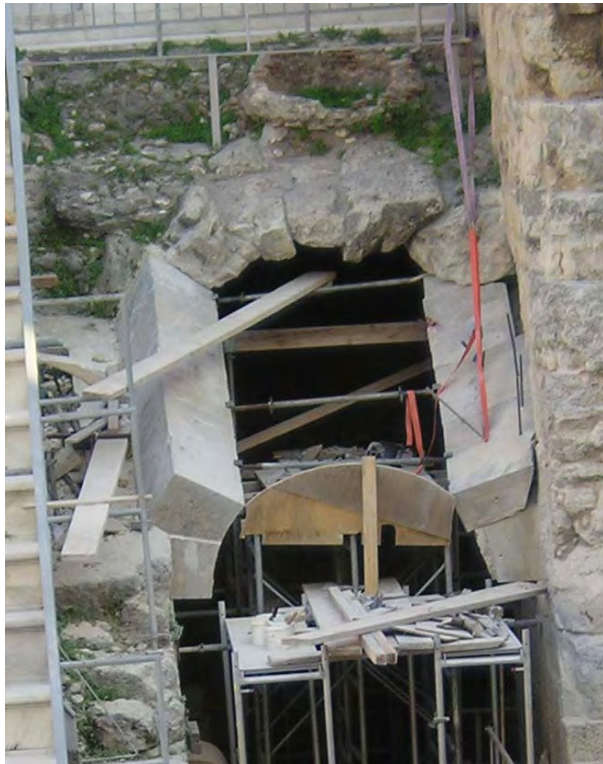
Τοποθέτηση των θολιτών και προσαρμογή του κλειδιού στην τελική τους θέση.
