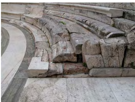
Η μαρμάρινη απόληξη του πώρινου στηθαίου και η οριζόντια μαρμάρινη κουπαστή.
