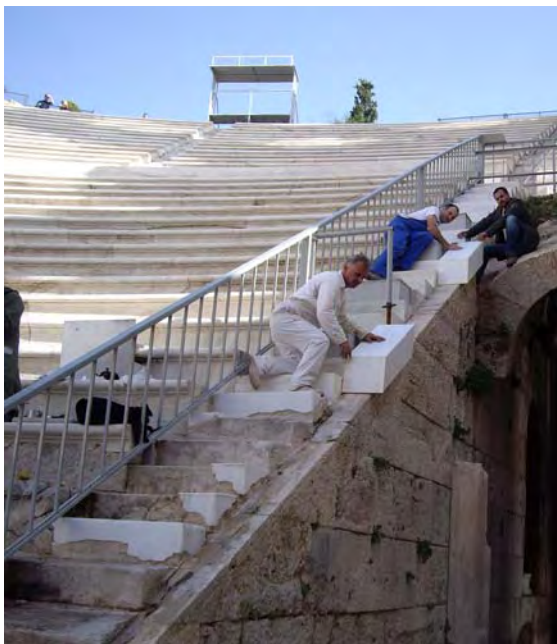
Εργασίες τοποθέτησης του μαρμάρινου στηθαίου στην Ανατολική ακραία κλίμακα του κοίλου. Το μαρμάρινο στηθαίο μετά την ολοκλήρωση των εργασιών.
