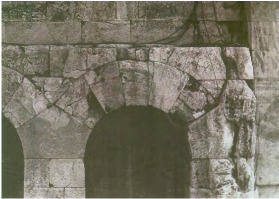
Το Ανατολικό τόξο του Νότιου τοίχου της σκηνής πριν και μετά την στερέωση και αποκατάσταση του.
