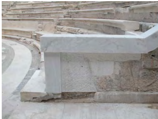
Η μαρμάρινη απόληξη του πώρινου στηθαίου και η οριζόντια μαρμάρινη κουπαστή.
