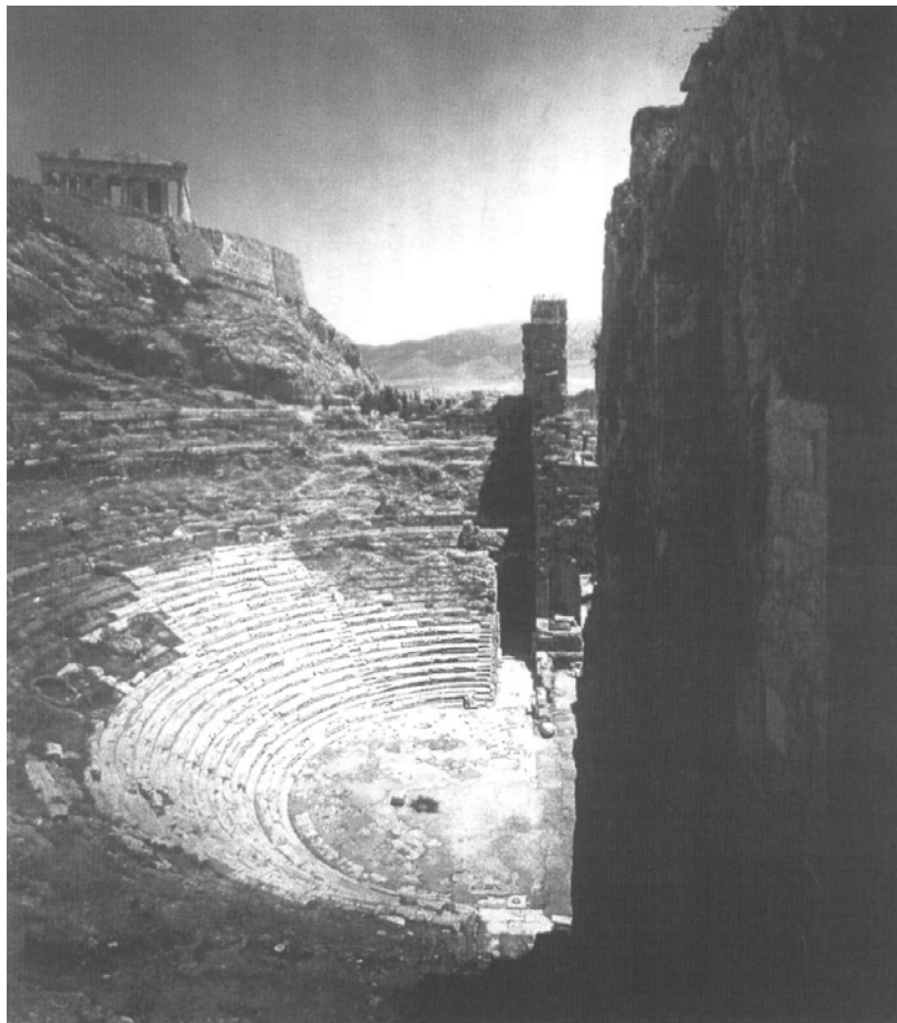
Άποψη του κόιλου πριν την αναστήλωση της δεκαετίας '50-'60.
