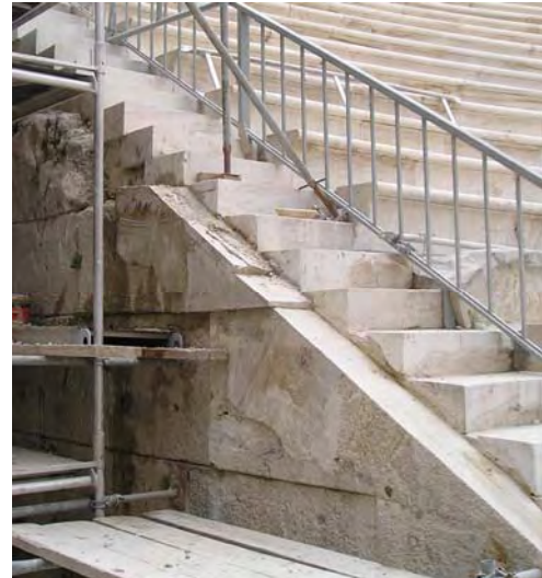
Το πώρινο στηθαίο της ακραίας δυτικής κλίμακας πριν και μετά την αναστήλωση.
