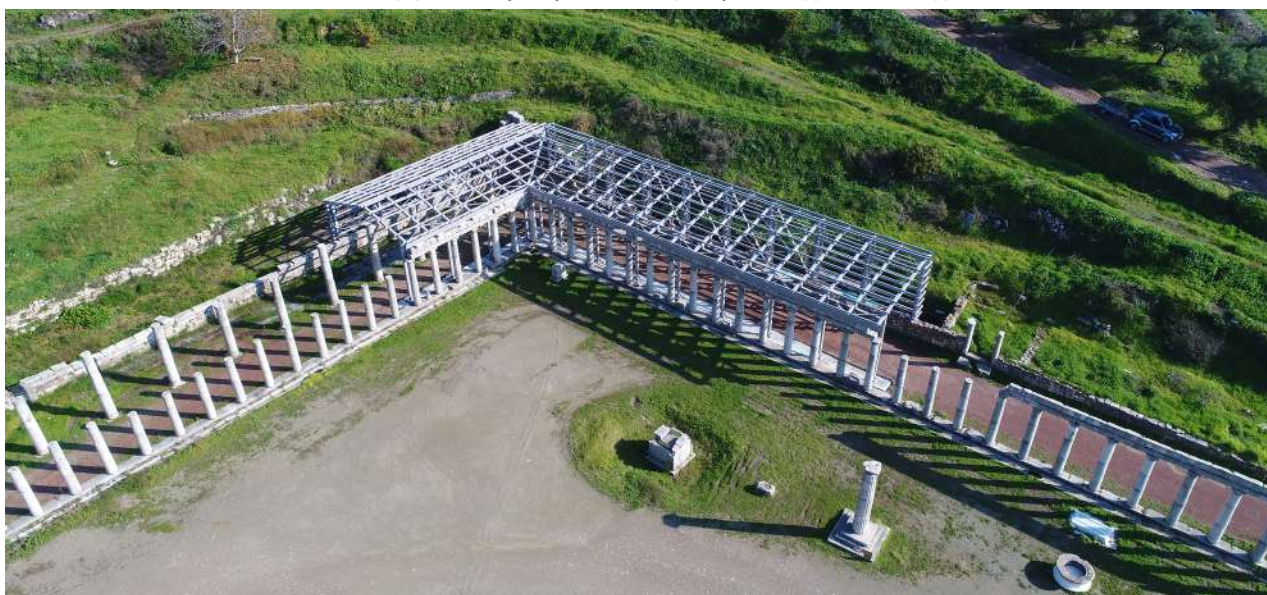
2. Άποψη του στεγάστρου κατά τη διάρκεια της κατασκευής.
