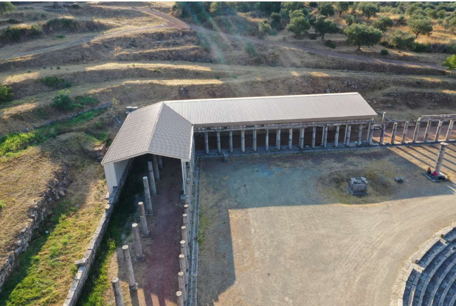
16. Άποψη του μεταλλικού στεγάστρου από Δ.
