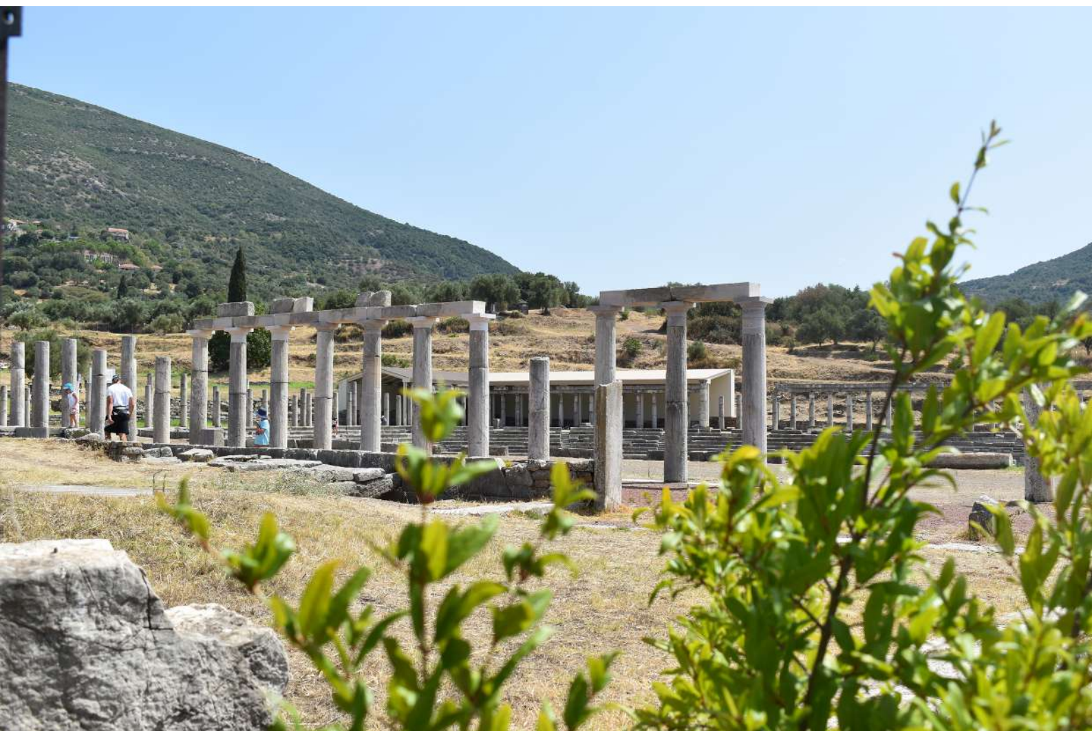
17. Άποψη του στεγάστρου από ΝΔ, μέσω της δυτικής στοάς.
