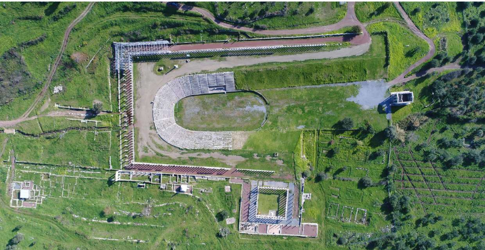
1. Γενική άποψη του συγκροτήματος Σταδίου-Γυμνασίου-Παλαίστρας.
