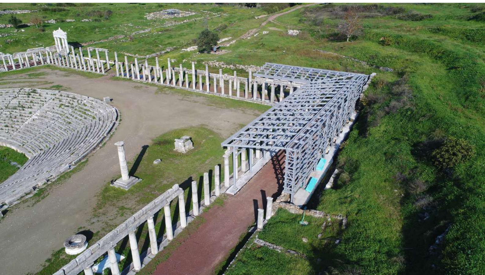
14. Ο μεταλλικός σκελετός του στεγάστρου κατά την κατασκευή.
