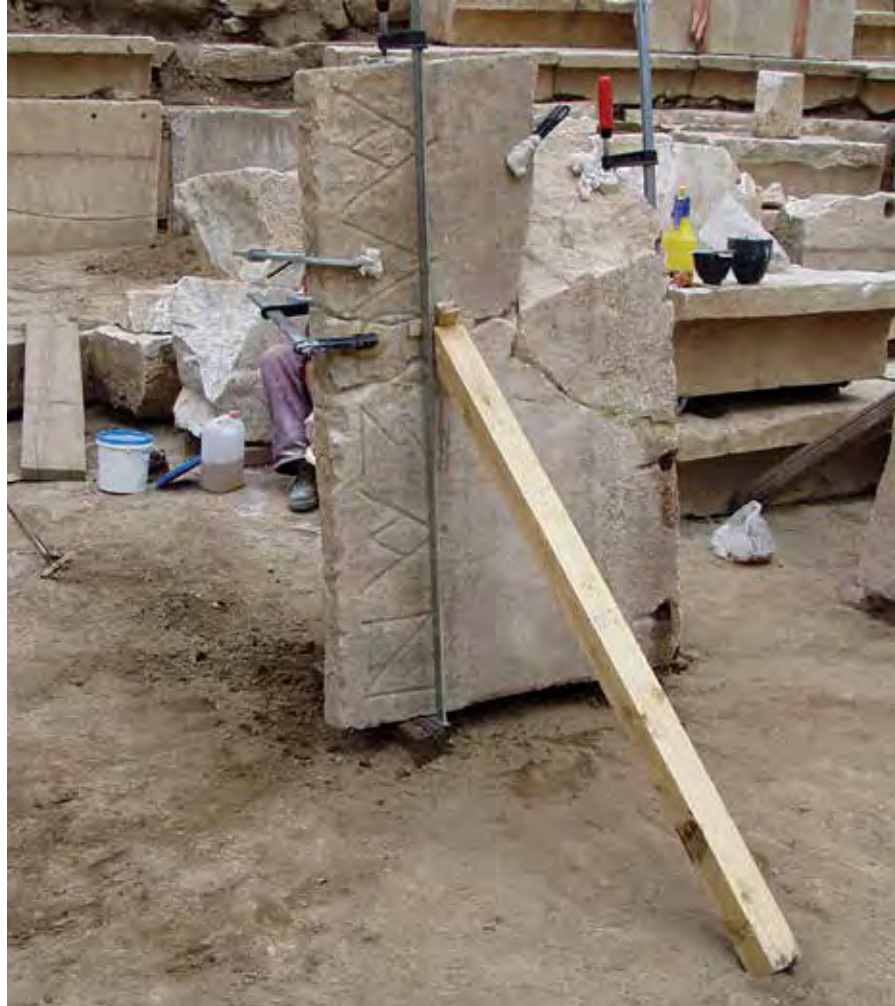
Συγκόλλησεις διάσπαρτων εδωλίων.
