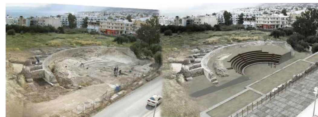
Εικ. 7: Θέατρο Χερσονήσου (πριν την έναρξη και μετά την ολοκλήρωση των εργασιών αποκατάστασής του).
