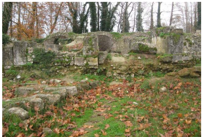
Άποψη από σύμπλεγμα με σφηνοειδείς καμάρες που λειτουργούν ταυτόχρονα ως στατικό και λειτουργικό υπόβαθρο του θεάτρου
