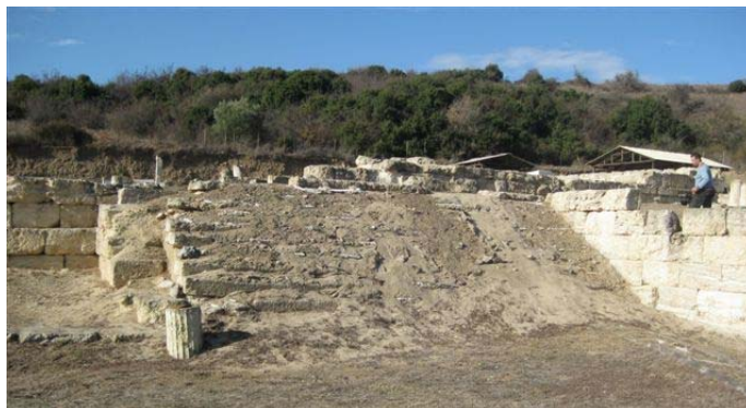
Άποψη της περιοχής «Σκαλάκια», όπου φαίνεται η κατάχωση της παλιάς κλίμακας
