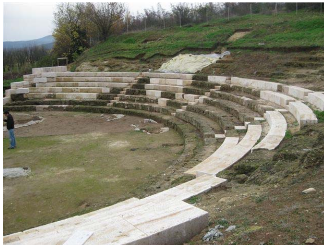
Άποψη του κοίλου του θεάτρου, όπου με το ανοιχτόχρωμο χρωματισμό διακρίνονται τα νέα εδώλια
