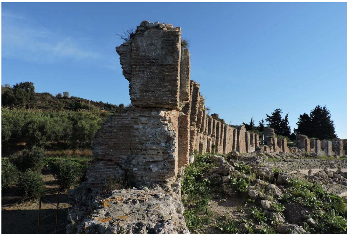
Εικ.5. Το θέατρο της Νικόπολης. Ο τοίχος της περιμετρικής στοάς. Διακρίνονται μορφολογικά στοιχεία και παραμορφώσεις. Η κατασκευή διατηρεί σε μεγάλο ποσοστό το αρχικό ύψος της.
