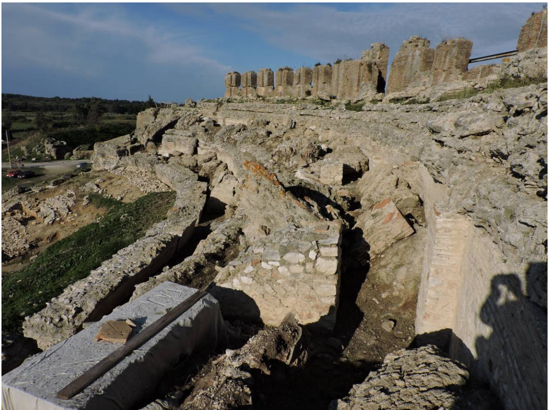
Εικ.8. Το θέατρο της Νικόπολης Αποψη των υποδομών του κοίλου στο άνω διάζωμα. Διακρίνεται αριστερά ασβεστολιθικό εδώλιο.
