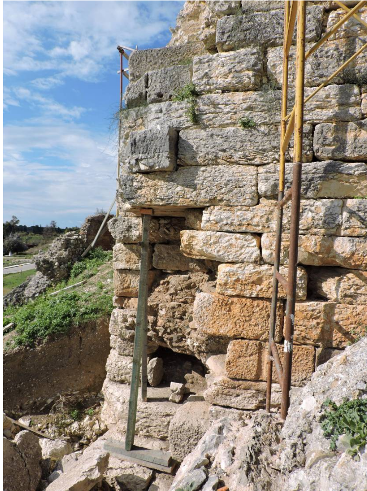
Εικ.6. Το θέατρο της Νικόπολης. Άποψη του νότιου αναλημματικού τοίχου. Διακρίνονται τα κενά του θώρακα.
