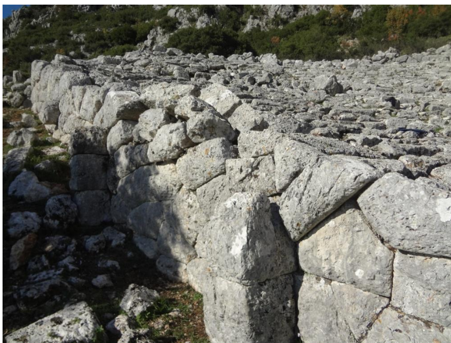
10. Λεπτομέρεια του δυτικού αναλημματικού τοίχου του κοίλου μετά τις εργασίες αποψιλώσεων. (λήψη: Διάζωμα/2012)
