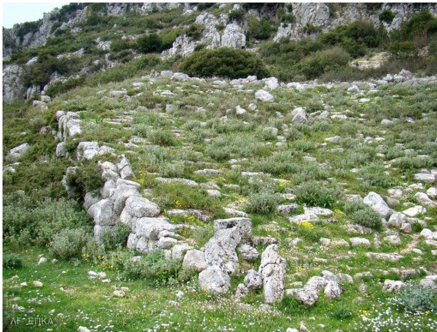
8. Γενική άποψη του δυτικού αναλημματικού τοίχου του κοίλου πριν τις εργασίες αποψιλώσεων.(πηγή: www.diazoma.gr )
