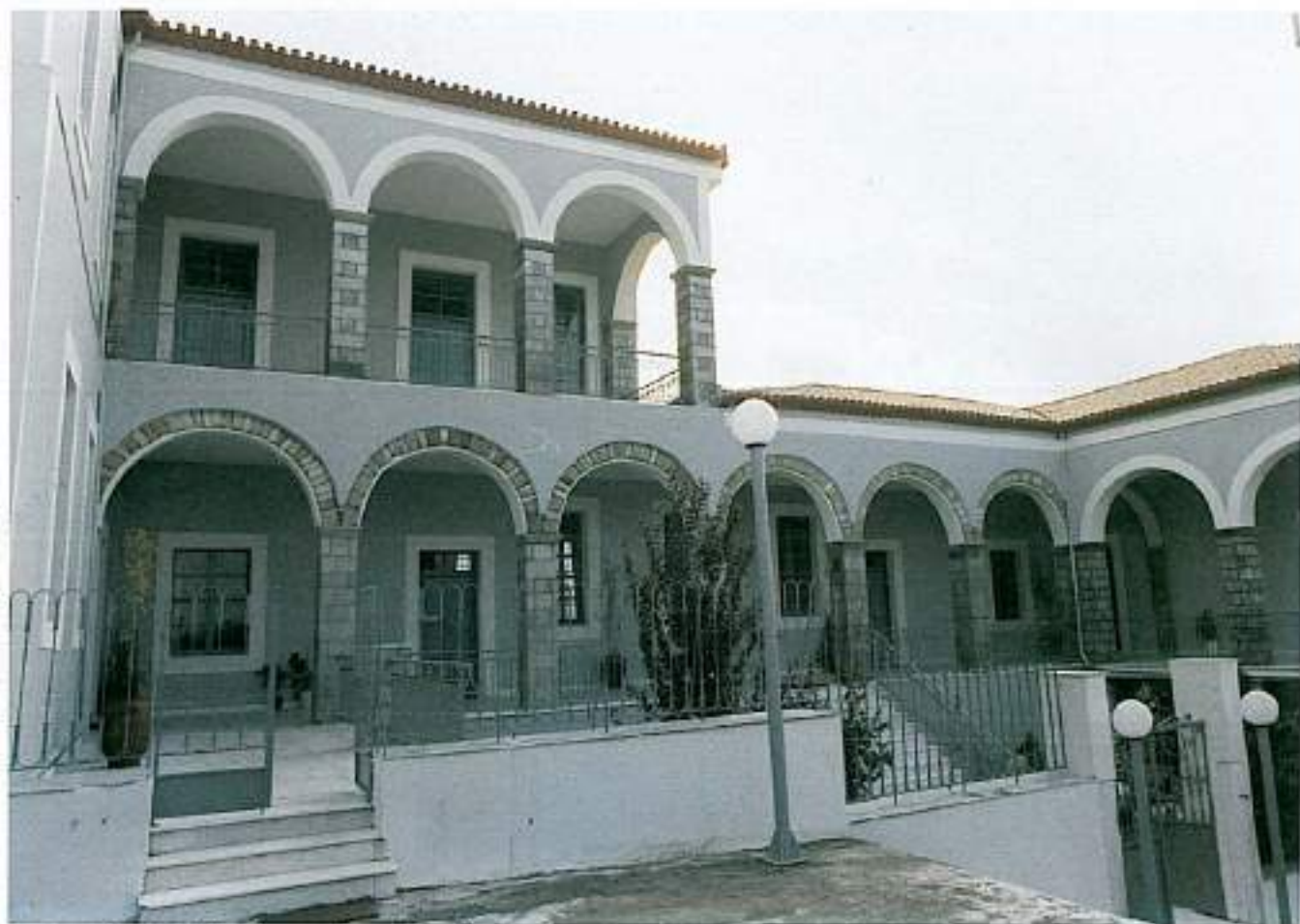
Το Δημοτικό Ωδείο Καλαμάτας μετά την επισκευή του.
