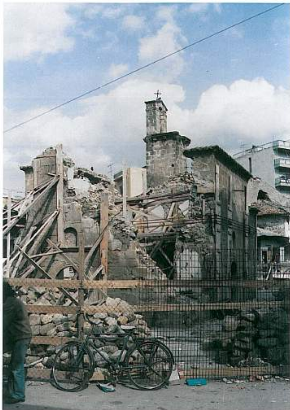
Ο ιστορικός ναός των Αγίων Αποστόλων της Καλομάτας, μετά την καταστροφή
