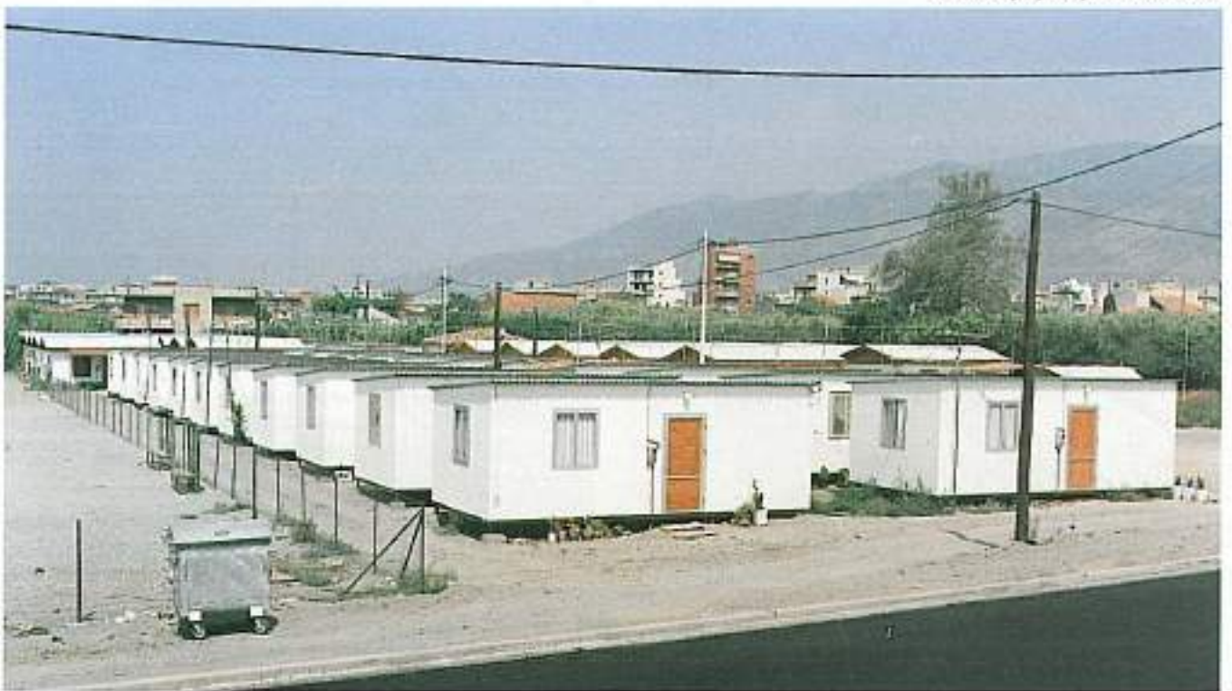
Καταυλισμός λυομένων κατοικιών.
