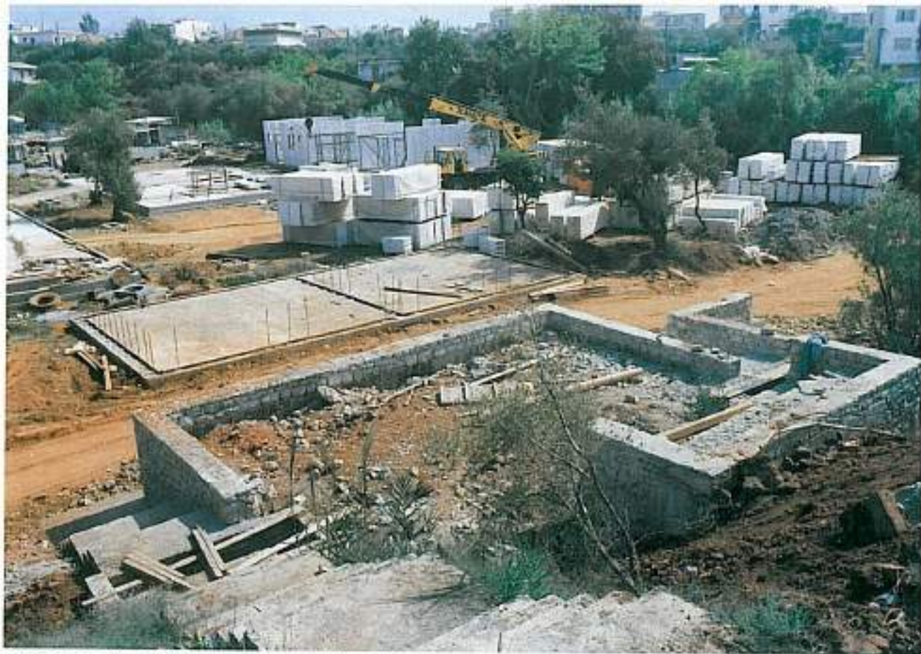
Αποψη από τα έργα διαμόρφωσης του Δυτικού Κέντρου Γεγονιάς.
