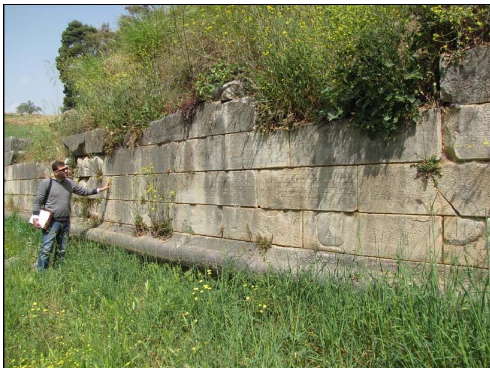
Εικ. 6: Επένδυση αναλήματος ανατολικής παρόδου.
