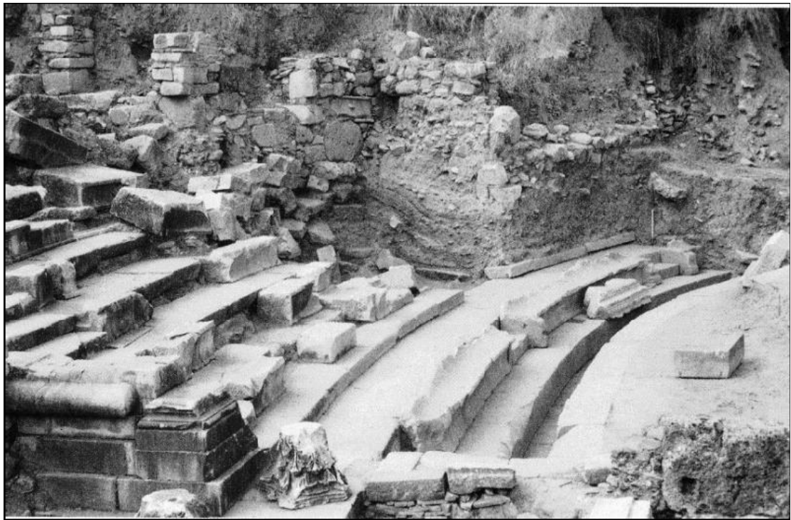
Εικ. 9: Η κατάσταση του ανατολικού τμήματος του κοίλου περί το 1993. Είναι καθαρισμένα: ο αγωγός, οι προεδρίες, ο διάδρομος πίσω από αυτές και φαίνονται τα θεμέλια των μεσαιωνικών κτισμάτων. (Waywell G.B. Wilkes J.J. 1995).
