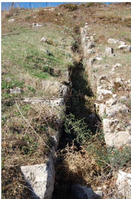
Ο λίθινος κτιστός αγωγός απορροής όμβριων υδάτων και λεπτομέρεια από την τοιχοποιία της. (Πηγή: ΛΘ' ΕΠΚΑ)
