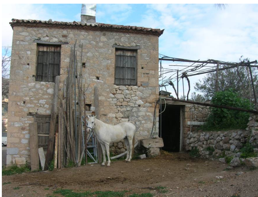
Άποψη του κτιρίου από νότια – Δεξιά φαίνεται το πρόσκισμα του στάβλου.
