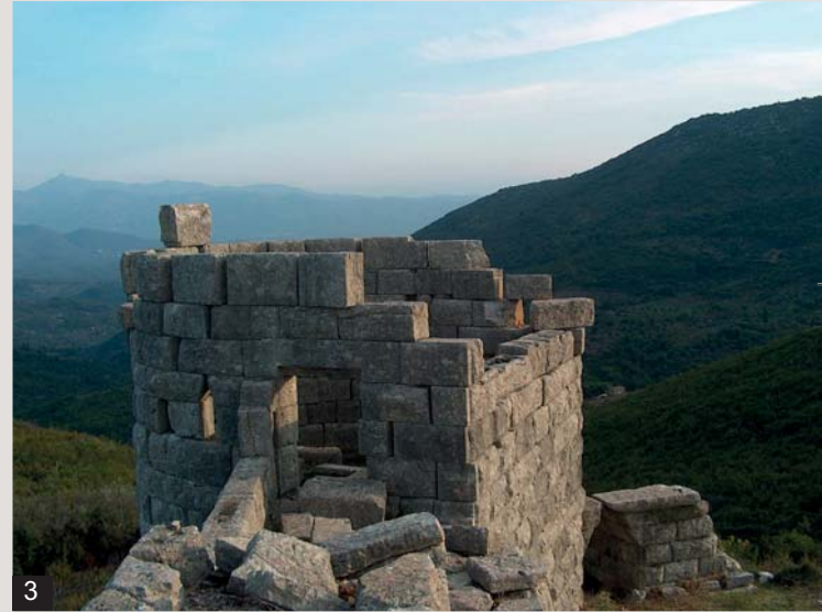
3. Πεταλόσχημος πύργος της οχύρωσης
