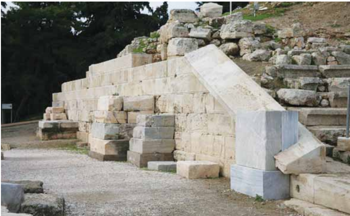
Το ανάλημμα της δυτικής παρόδου μετά την αποκατάσταση. Σε πρώτο πλάνο, το αναστηλωμένο βάθρο του ποιητή Αστυδάμαντα
