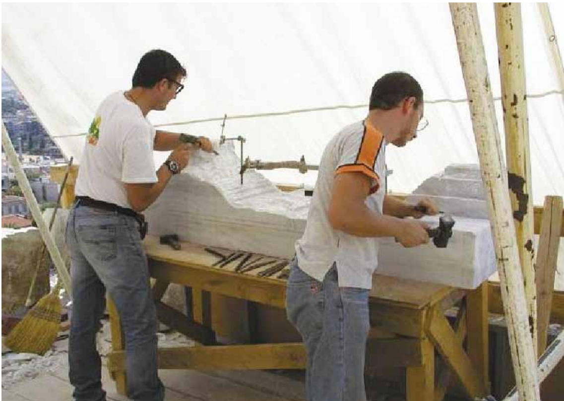
Εργασίες συντήρησης και συμπλήρωσης των αρχιτεκτονικών μελών του μνημείου
