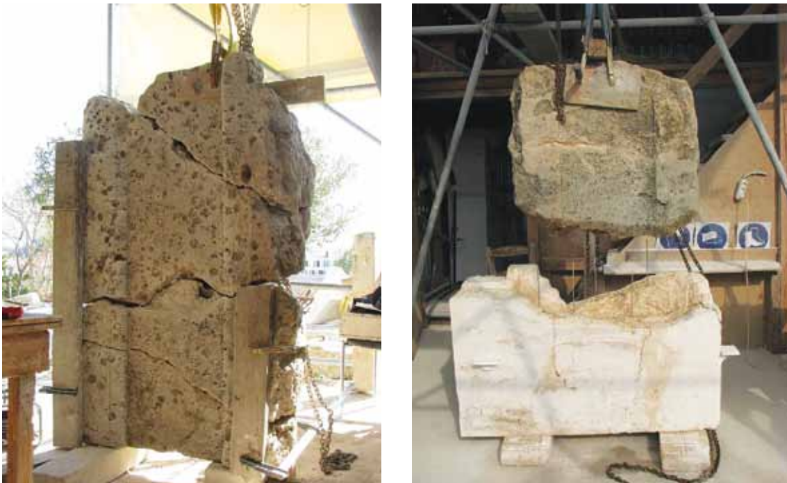
Εργασίες συγκόλλησης (αριστερά) και συμπλήρωσης (δεξιά) εδωλίων από την κεντρική κερκίδα του Θεάτρου
