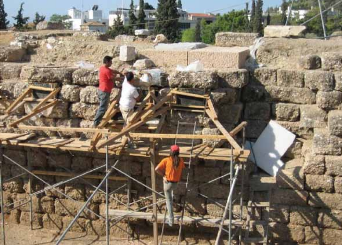
Χύτευση συμπληρωμάτων των κροκαλοπαγών λίθων του αναλήμματος
