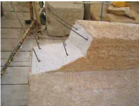
Εργασίες συντήρησης και συμπλήρωσης των αρχιτεκτονικών μελών του μνημείου
