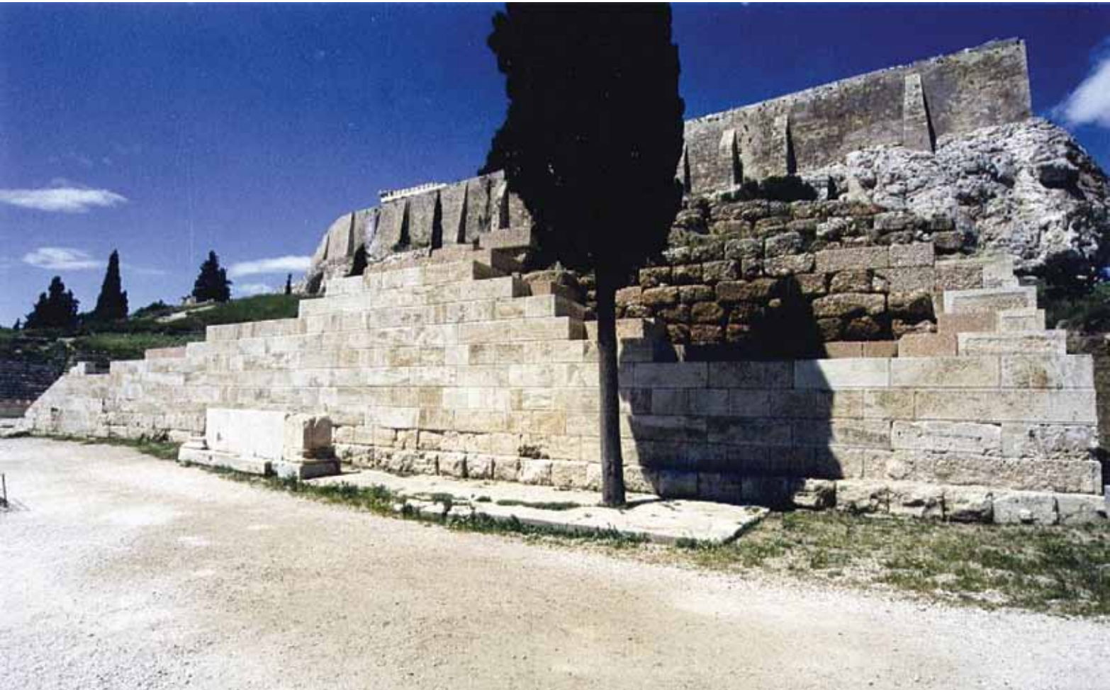
Το ανάλημμα της ανατολικής παρόδου μετά την ολοκλήρωση των εργασιών
