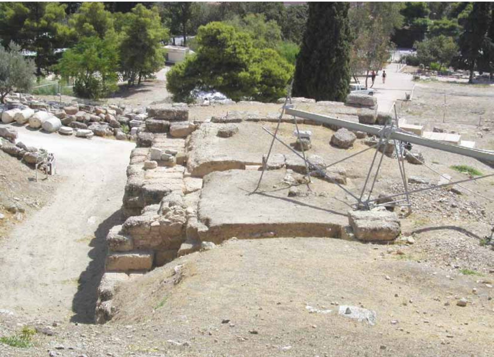
Το ανατολικό πλευρικό ανάλημμα κατά τη διάρκεια των εργασιών. Διακρίνονται οι ανασκαφικές τομές στη θέση των αντηρίδων
