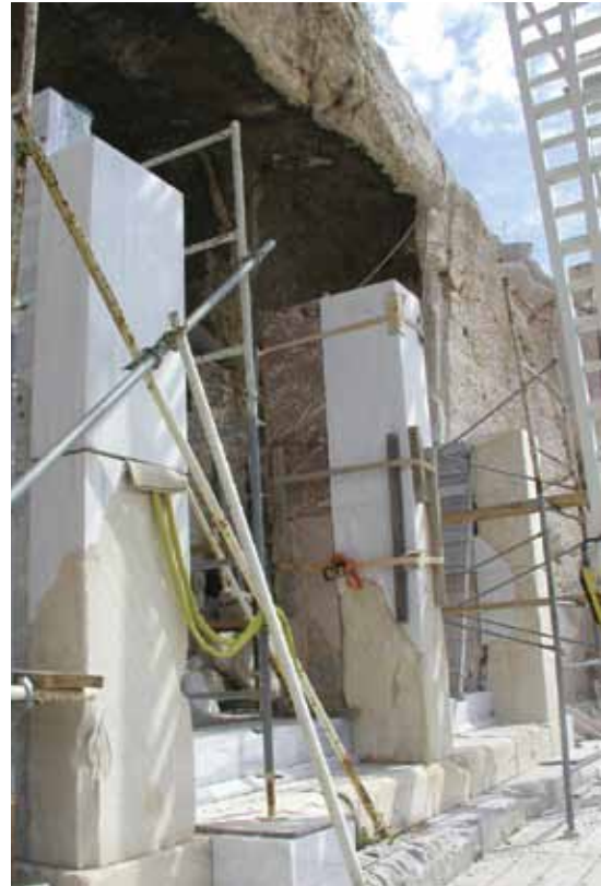
Το χορηγικό μνημείο του Θρασύλλου, κατά τη διάρκεια των εργασιών
