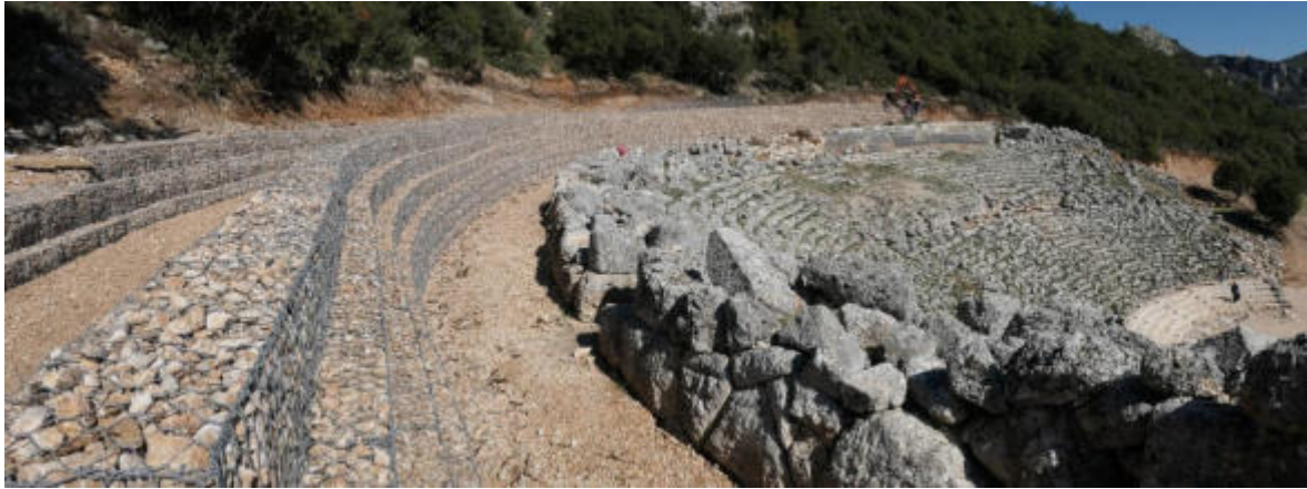
Εικόνα 4. Ολοκληρωμένη η βραχοπαγίδα στην πλάτη του θεάτρου. Picture 4. Constructed rockfall trap at the back of the theatre.
