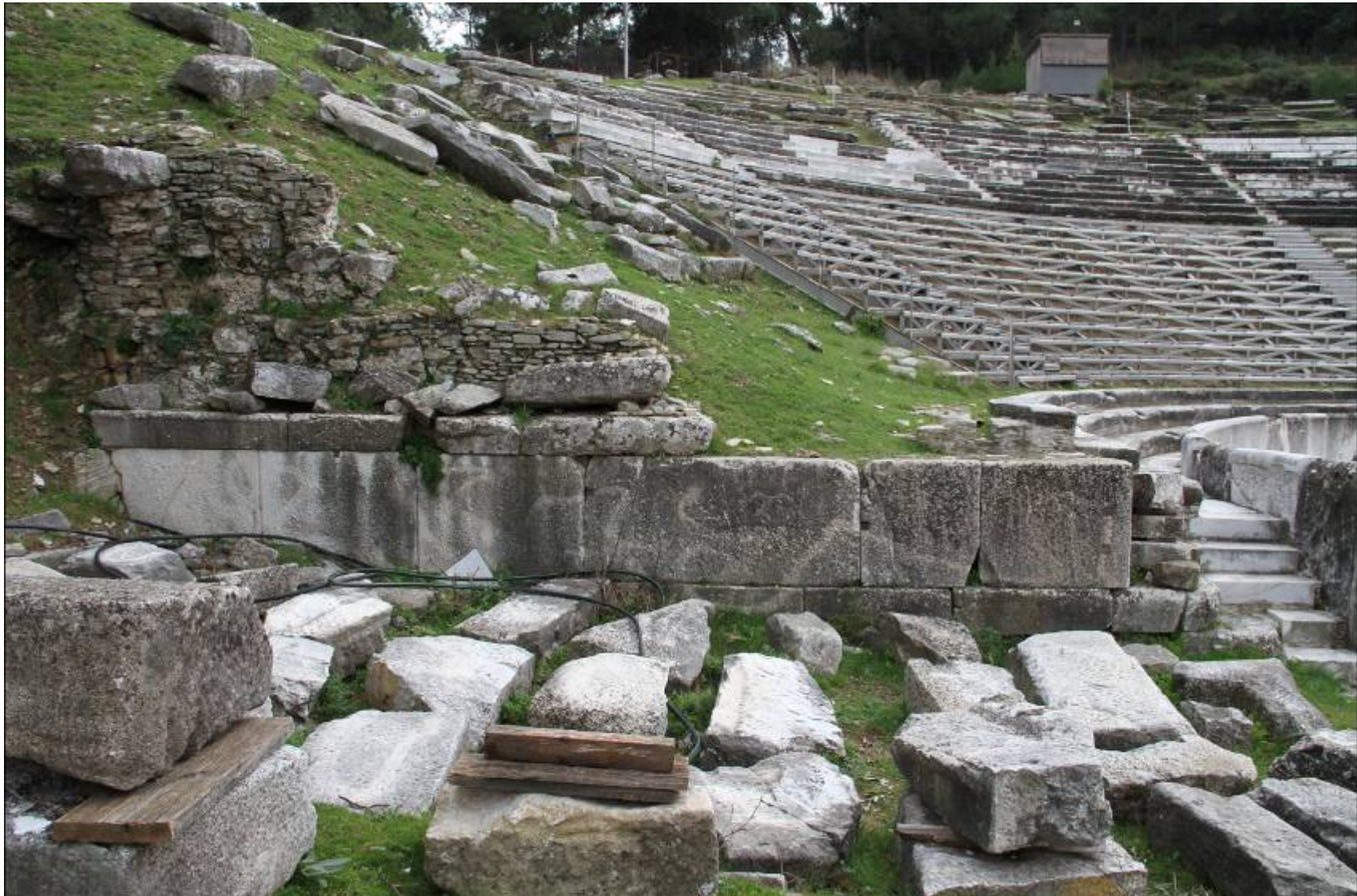
Εικ.: Εργασίες από τον καθαρισμό της Ανατολικής παράδου
