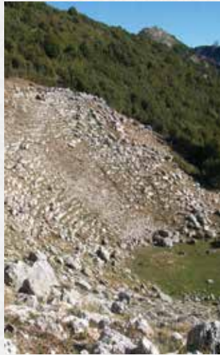
Άποψη κοίλου και πυλίδας στον εξωτερικό αναλημματικό τοίχο
