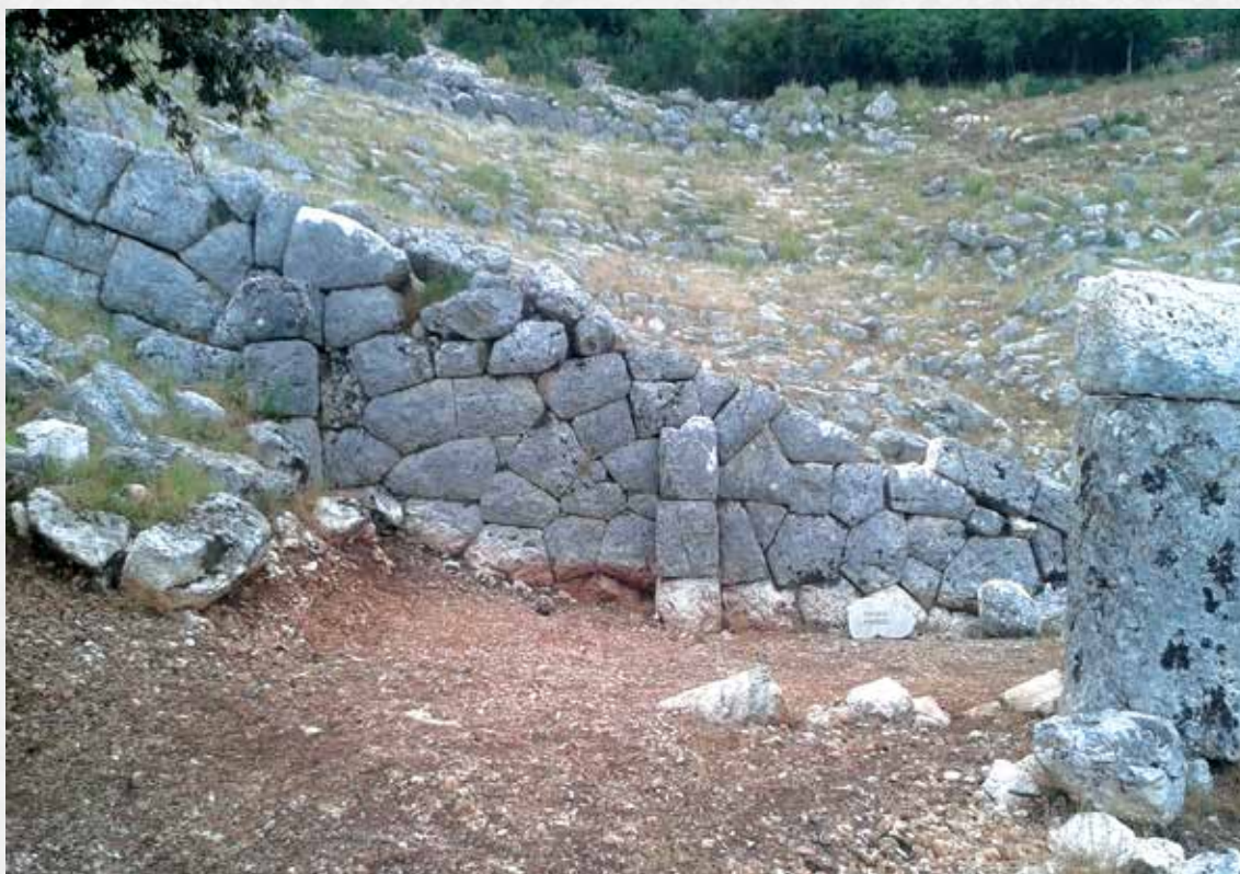
Θέατρο. Ο δυτικός αναλημματικός τοίχος του κοίλιου μετά τις πρόσφατες εργασίες
